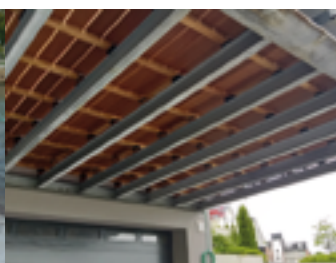
Beläge auf Stahlkonstruktionen
