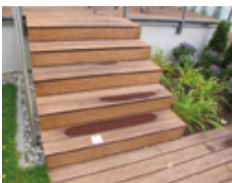
Treppe > 60 cm Höhe
