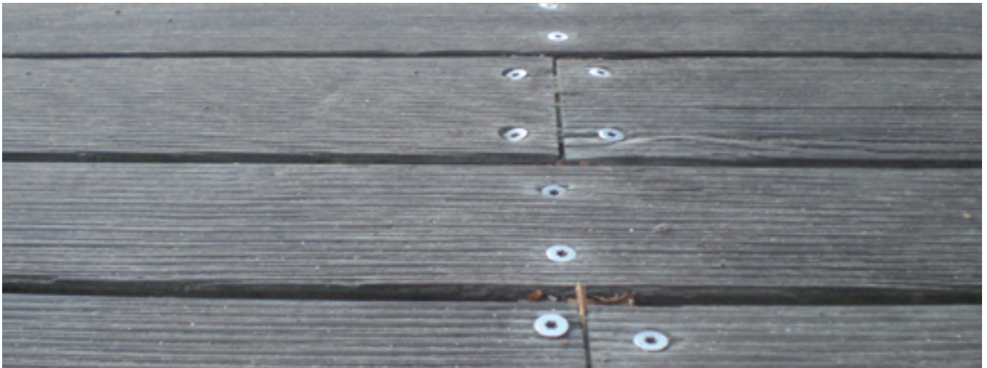
So sollte ein Schraubenbild nicht aussehen. Die Schrauben sind nicht in einer Flucht geschraubt.
