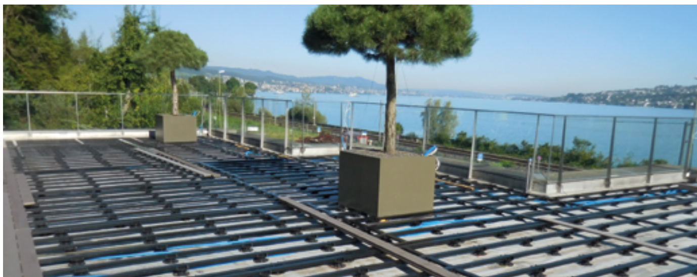
Aluminiumunterkonstruktion mit Stelzlagern und Verstellfüßen.
