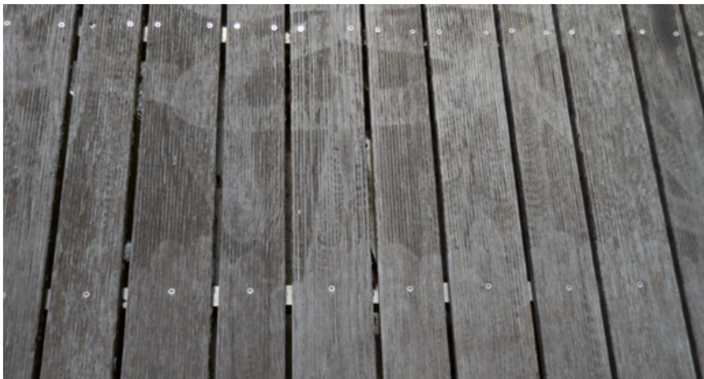
Die Fläche wurde mit einem Hochdruckreiniger gereinigt, wodurch sichtbare Farbunterschiede auf der Oberfläche entstanden sind.
