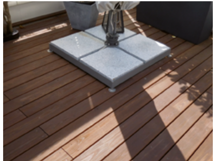
Bei Dachterrassen muss geprüft werden, ob schwere Sonnenschirmständer aufgestellt werden können.
