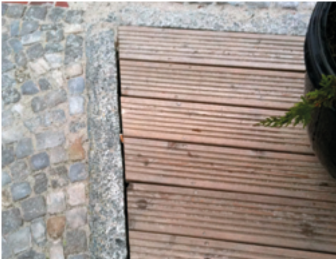
Bei Terrassen, die auf dem Niveau von Stein- und Rasenflächen erstellt werden, sollten dauerhafte Holzarten mit einer Dauerhaftigkeitsklasse DC 1-2 eingesetzt werden. Diese Einbausituation gilt Gebrauchsklasse GK 4.
