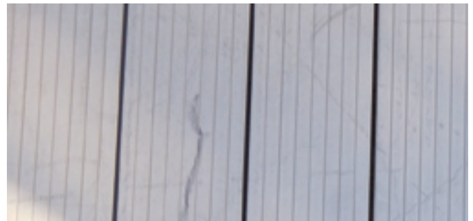
Auf WPC-Terrassen können Kratzer durch Möbelgleiter entstehen.
