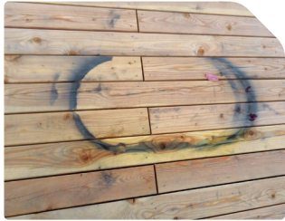
Verfärbung durch metallische Gegenstände
