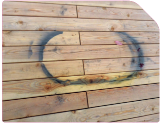
Verfärbung durch metallische Gegenstände
