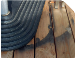
Verfärbung durch metallische Gegenstände
