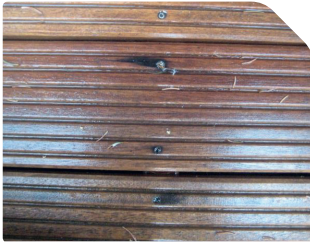
Reaktion der Holzinhaltstoffe mit Schrauben
