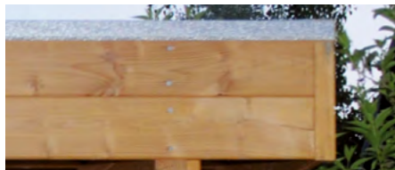
Umlaufende Blendenabdeckung aus Aluminium Stucco blank als Ergänzung für Flachdach-Holzblende.
