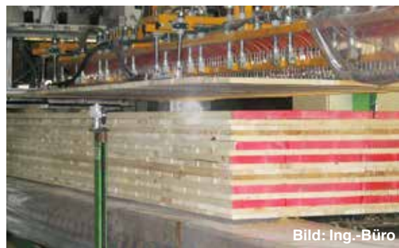
Abb. 9 Kreuzweises Auslegen der Brettlagen und Leimauftrag. Danach folgt der Pressvorgang.
