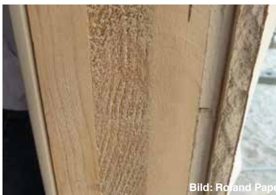
Abb. 68 Außenwand, die wegen Brandschutzanforderungen mit Gipswerkstoffplatten bekleidet wurde.
