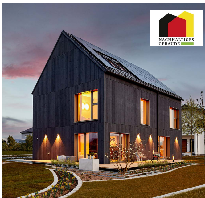
Das erste „QNG-Premium“ Haus in Deutschland, gebaut von BAUFRITZ, mit esb Plus Frischholz-Platten in Fichte von elka-Holzwerke (Foto: BAUFRITZ)
