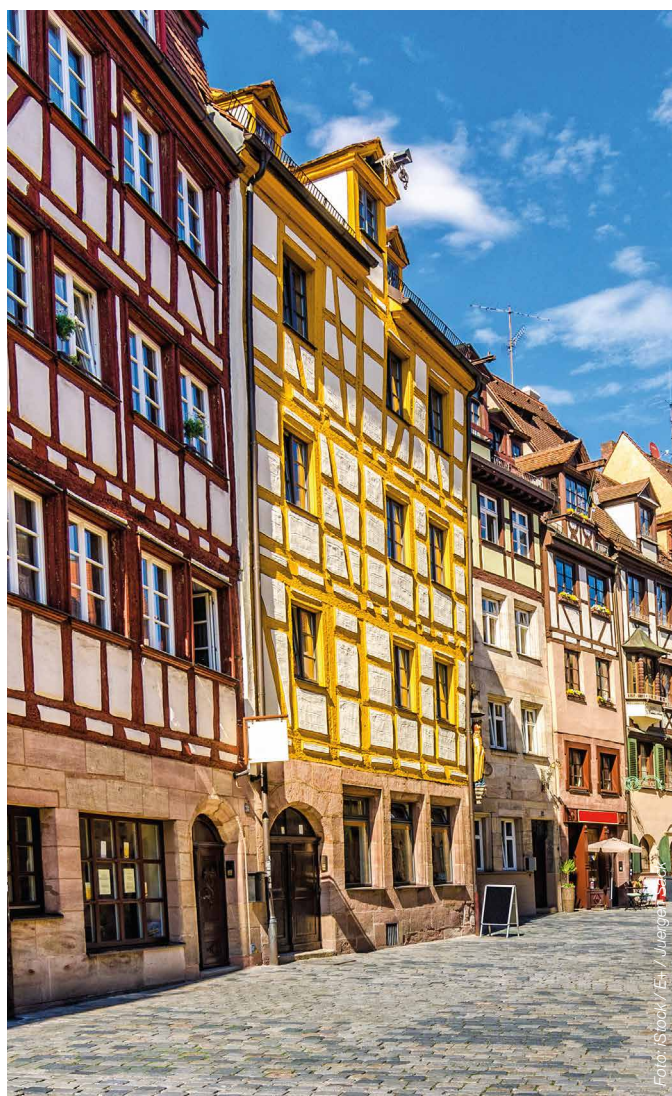
Fachwerkhäuser, eng beieinander – hier sprechen gleich zwei Gründe gegen eine Außen- und für eine Innendämmung
