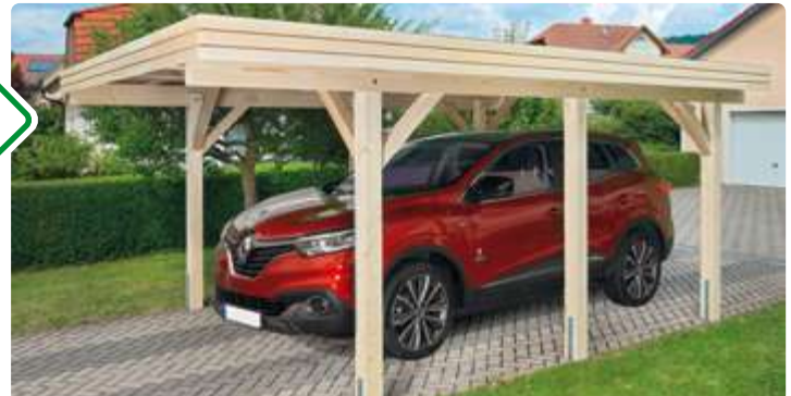
„Hamburg 1“ mit seitlichem Geräteraum
