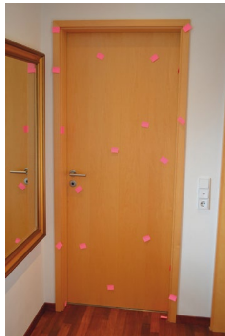
Eine solche Abnahmesituation ist nach den Regelwerken nicht zulässig.
