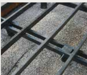
Unterkonstruktion PlasPro aus Recycling-Kunststoff
