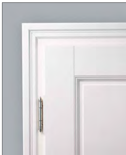
Der Falz und die Profilfräsung
