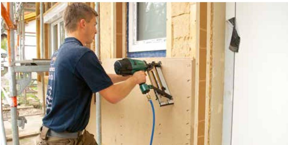
Abb. 2: Auf der Grundlattung können Holzfaserdämmplatten als Unterdeckung oder Putzträgerplatten (WDVS) sehr rationell mittels Breitrückenklemmern befestigt werden. Auch bei einer Mischfassade verbleiben alle Arbeiten in einem Gewerk.
