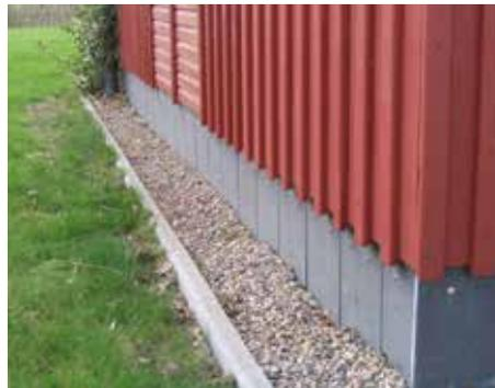
Abb. 2: Vertikalschalung mit ausreichender Sockelhöhe 300 mm. Der Sockel ist mit feuchteunempfindlichem Material bekleidet. Bei Kiesbett darf auf 150 mm reduziert werden.
