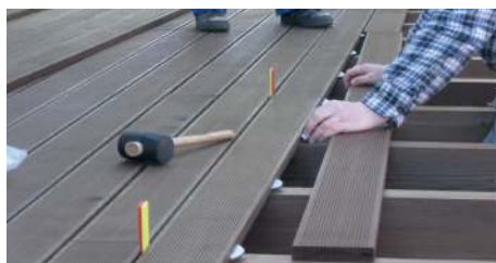
Abb. 10: Bei der Verlegung (Lieferfeuchte u = 16-18\% ) sollte eine mittlere Fugenbreite von 7 – 8 mm eingehalten werden.
